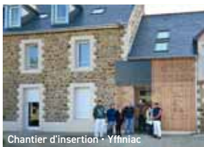
Chantier d'insertion - Yffniac
